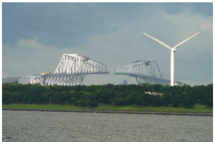
【写真;建設中の東京港臨海大橋(仮称)と若洲の風車】
